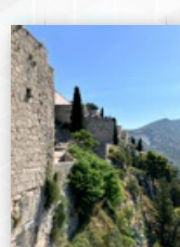
Die Burgmauern und Eingang der Festung Klis - I.
